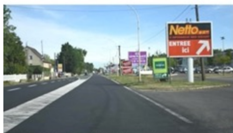
Impact visuel de lourds dispositifs répétés en entrée de ville
