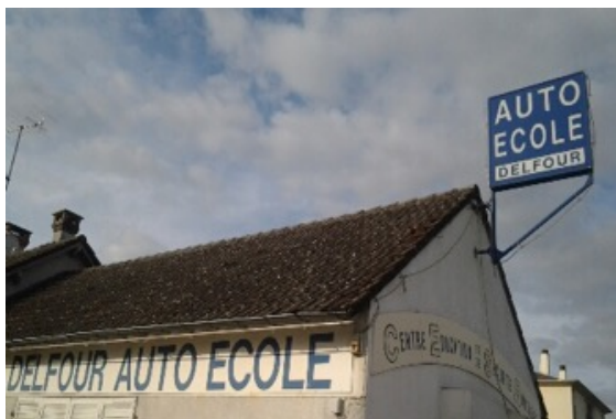
Enseigne perpendiculaire dépassant la limite supérieure du mur, Nemours, Septembre 2019
